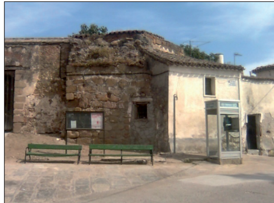
Elemento integrado en una construcción en la Puerta
